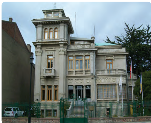
Edificio consistorial, comuna de Punta Arenas
